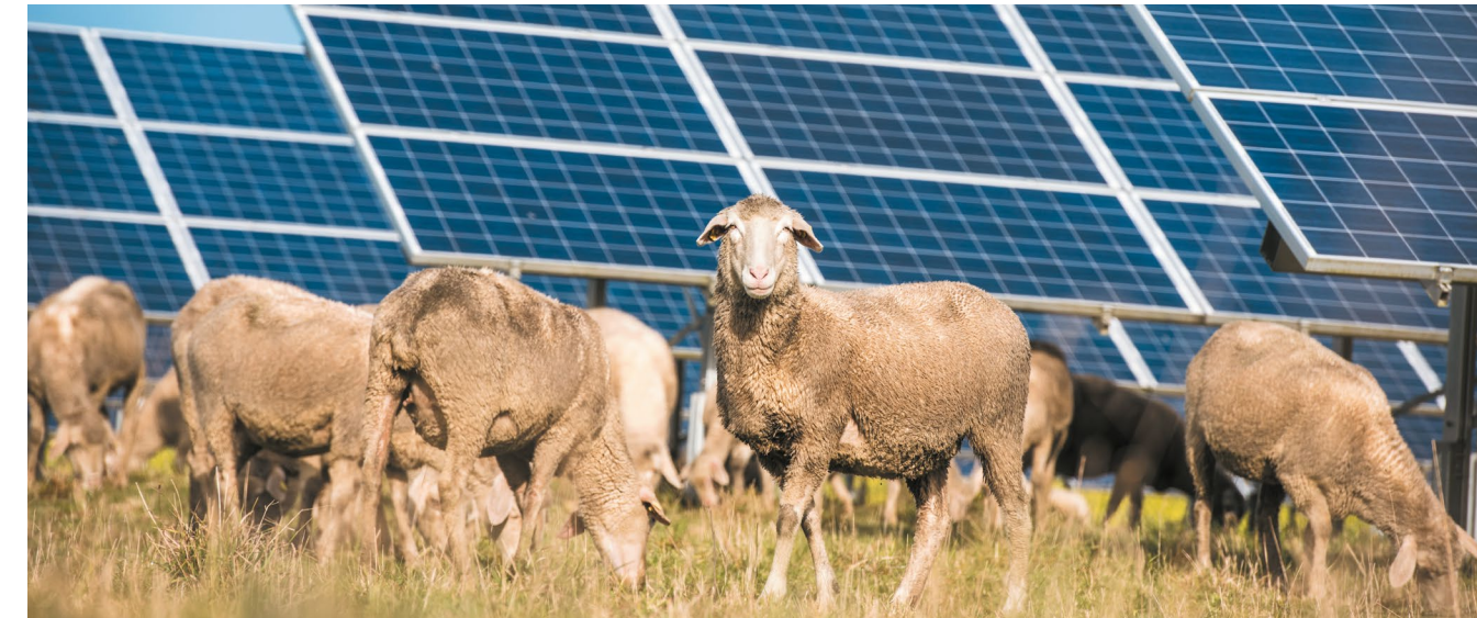
Ferme solaire à Montlhéry
